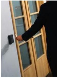
La fonctionnalité de contrôle d'accès étant intégrée dans le système, un utilisateur pourra en marge de la fonction d'enclenchement et de déclenchement classique pour un système de sécurité, permettra d'ouvrir une porte depuis un clavier ou un lecteur de badge.
